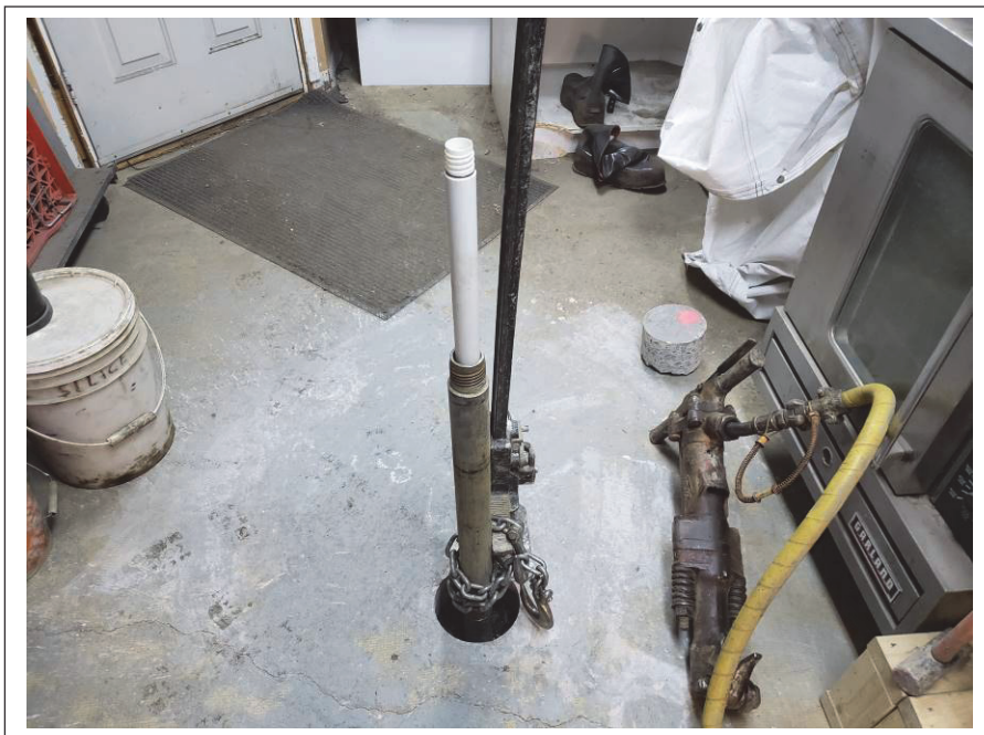
Photo 2 : Aperçu de l'aménagement du puits 20PO2; vue direction nord-ouest.
