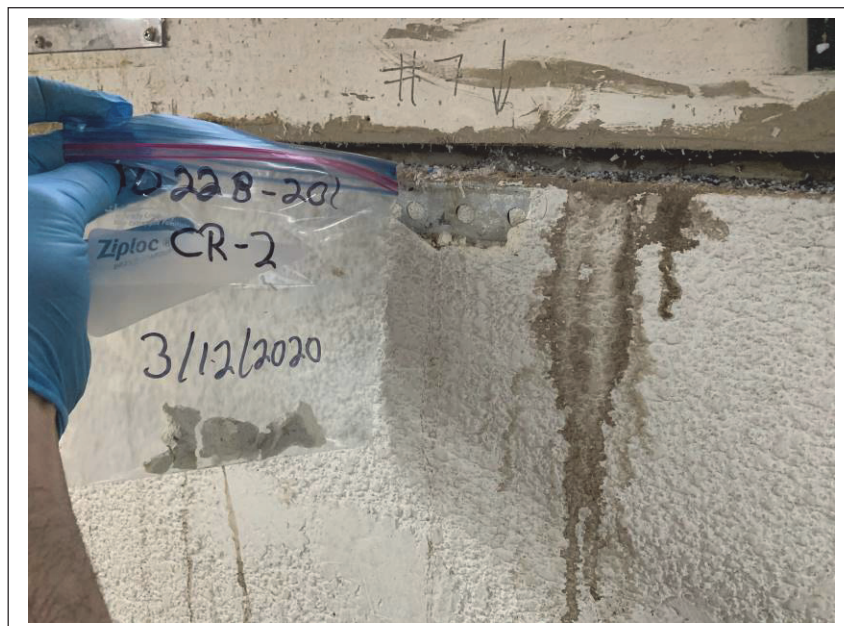
Photo 4 : Aperçu de l'échantillonnage du crépi de béton; vue direction sud-ouest.
